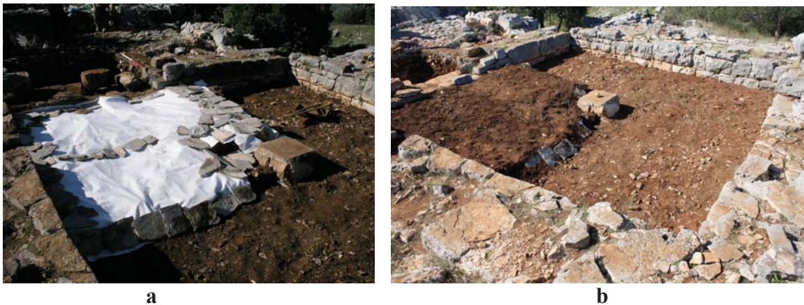
Sl. 4a i b. Geotekstil nad jugoistočnim kvadrantom (a) i zatrpani ostali dijelovi unutrašnjosti kule (b)
